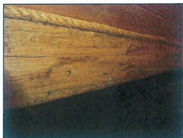
Traces de et séquelles d'insectes à larves xylophage de type vrillettes et capricornes
