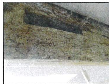
Traces de et séquelles d'insectes à larves xylophage de type vrillettes et capricornes
