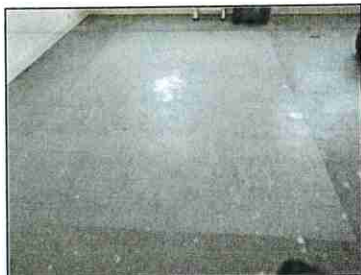
Photo N° 004 -1er-Séjour_1er - Planchers - Dalles de sol 30x30
