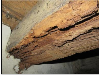
Traces de Coniophore (Pourriture cubique)
