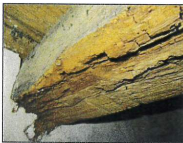
Traces de Coniophore (Pourriture cubique)
